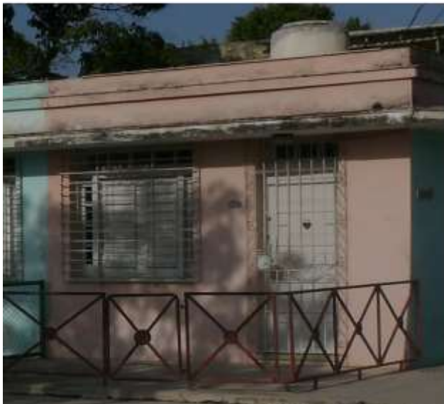
Puertas y ventanas con balaustres
