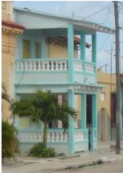
Edificación de 2 niveles con cercados y viguetas y planchetas en entrepiso y cubierta.
