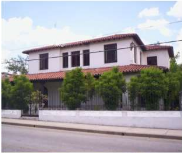
Carretera Central y Unión
