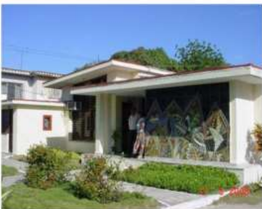
Carretera Central, banda Placetas
