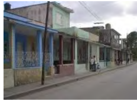
Viviendas con portales Ave 7 de Diciembre
