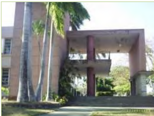
Rectorado/Grado de Protección I
