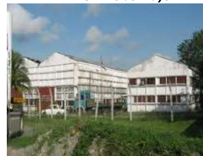
Zona de Almacenes
