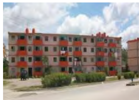
Edificios Reparto Bengochea
