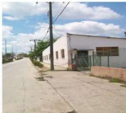
Esc. Fructuoso Rodríguez Doble Vía y Carretera Central
