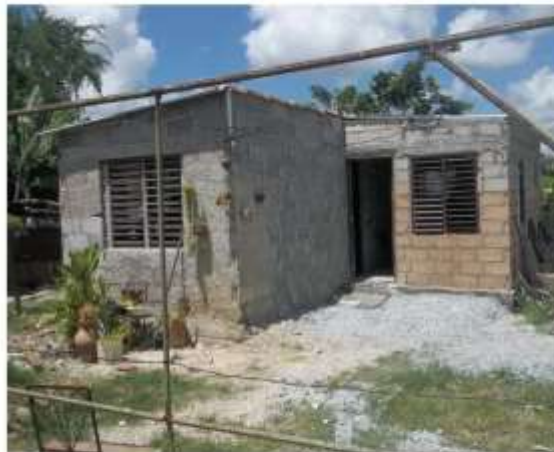
Vivienda en Zona Planta de Purificación
