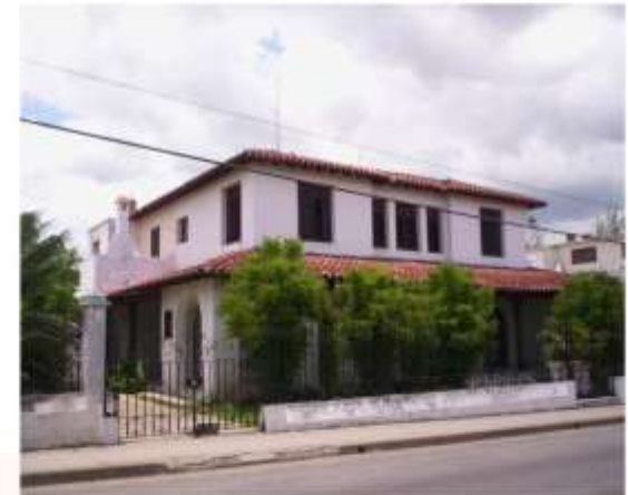
Carretera Central y Unión
