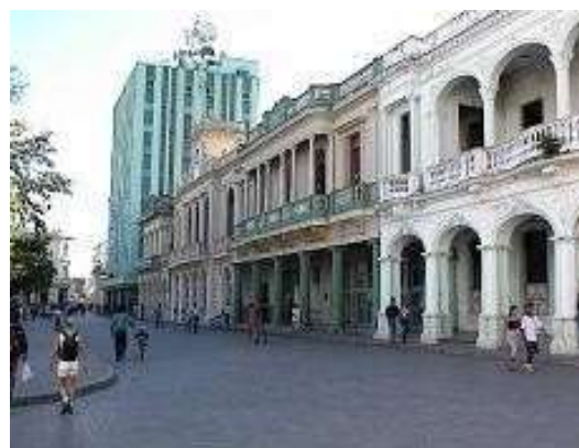
Fachada oeste Parque Vidal
