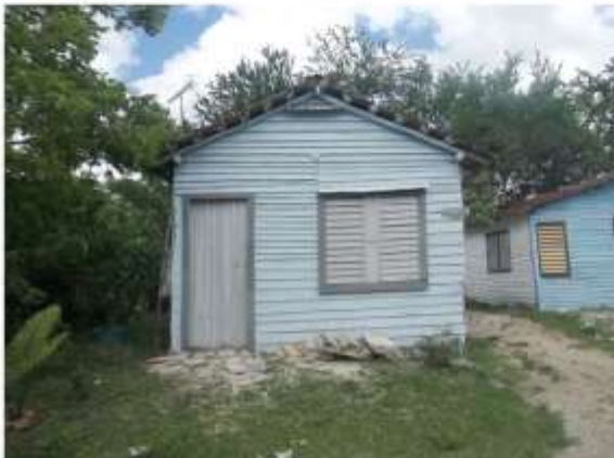
Vivienda en Zona Planta de Purificación
