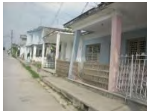
Fachadas en Zona de Protección
