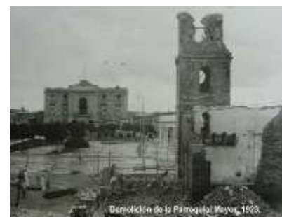
Demolición de la Parroquial Mayor. 1923
