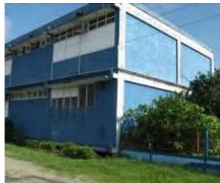
Instalaciones Empresa eléctrica
