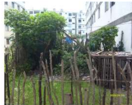
Edificios multifamiliares Rpto. José Martí
